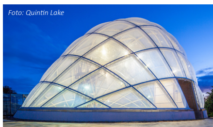
Figur 3: Væksthusets stålbuer løftes på plads i sektioner til det færdige resultat med ETFE-puder
