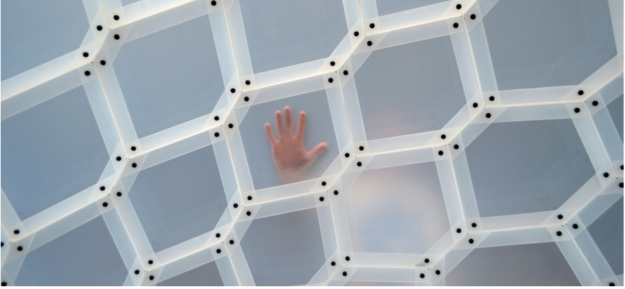
Figur 1: Translucent materiale med samlingsdetaljer udført med sorte plastnitter
